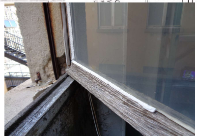
Ech 35 : TC-R+3 ARCHIVES 3 Fenêtre G - MASTIC : PRESENCE D'AMIANTE
