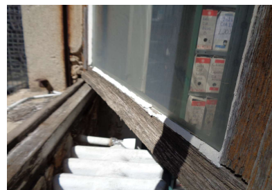
Ech 37 : TC-R+3 ARCHIVES 4 Fenêtre H - MASTIC : PRESENCE D'AMIANTE
