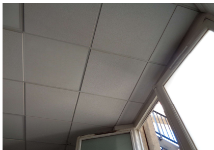
Ech 26 : TJ-R+2 SALLE AUDIENCE 3 (Fenêtres V-U-T-S) - FAUX PLAFOND: SANS AMIANTE
