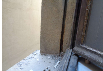
Ech 20 : TC-R+1 BUREAU 1 (Fenêtres O-P-Q-R) - ENDUIT FACADE : SANS AMIANTE
