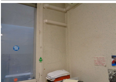
Ech 4 : TC-RDC BUREAU (Fenêtre B) + ARCHIVES (Fenêtre C-D) - ENDUIT MURAL : SANS AMIANTE
