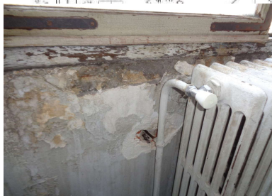
Ech 13 : TC-R+3 ARCHIVES 3 (Fenêtre G) - ENDUIT MURAL + EMBRASURE : SANS AMIANTE
