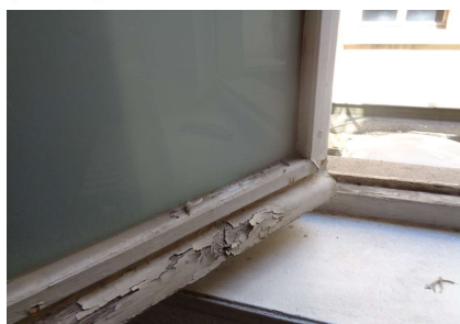
Ech 23 : TJ - R+2 SALLE AUDIENCE 3 Fenêtres V-U-T-S - JOINT : SANS AMIANTE
