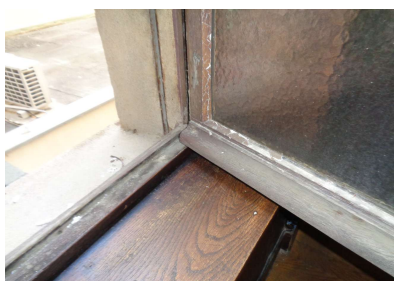
Ech 15 : TC-R+2 SALLE AUDIENCE Fenêtres N-M-J-K-L - MASTIC : SANS AMIANTE
