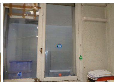
Ech 3 : TC-RDC BUREAU Fenêtre B - MASTIC : SANS AMIANTE
