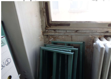
Ech 39 : TC-R+3 ARCHIVES 4 (Fenêtre H-I) - ENDUIT MURAL + EMBRASURE : SANS AMIANTE
