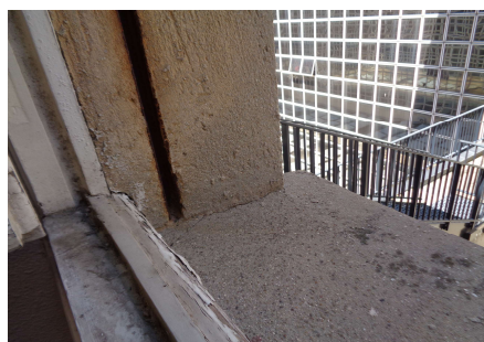
Ech 33 : TJ-R+3 SALLE AUDIENCE (Fenêtre AA) - ENDUIT FACADE : SANS AMIANTE
