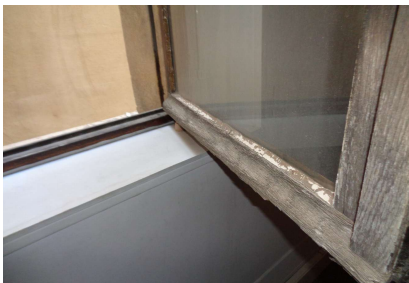
Ech 18 : TC-R+1 BUREAU 1 Fenêtres O-P - MASTIC : SANS AMIANTE
