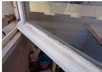
Ech 27 : TJ-R+4 BUREAU 320 Fenêtre Z & BUREAU 321 Fenêtre Y - JOINT : SANS AMIANTE
